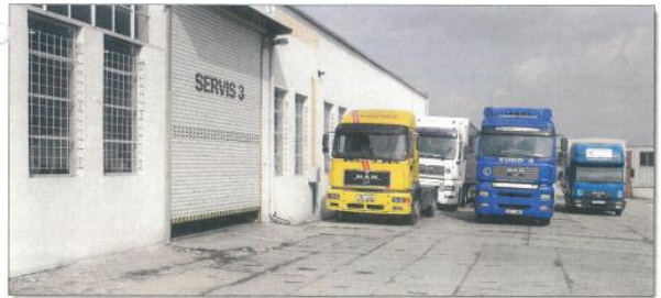
Pohled na servisní halu
