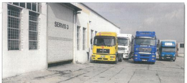
Pohled na servisní halu
